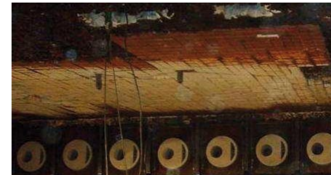
Umbau einer Zone von „normalen Brennern“ in Ultra Low NOx Brenner Typ 1610
