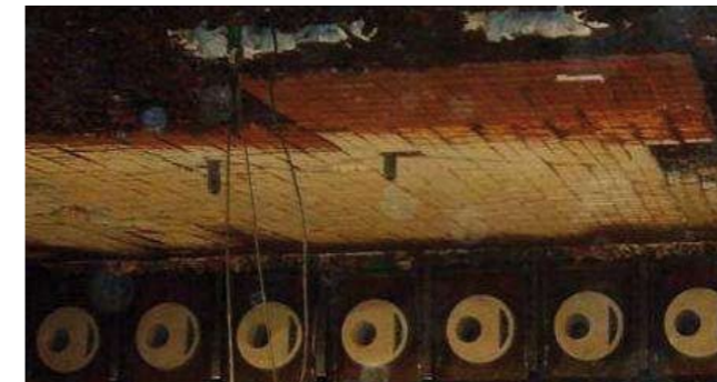
Umbau einer Zone von „normalen Brennern“ in Ultra Low NO x -Brenner 1610
